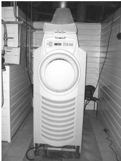
Рис. 4. Газовая турбина с электрогенератором 60 кВт с аккумуляторной батареей для автономного запуска и системой утилизации тепла
